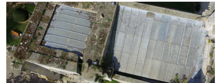
Toiture en zinc, 2017.
