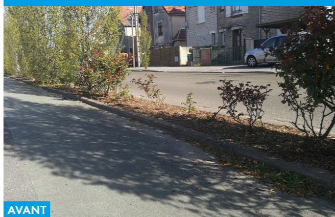
ARASEMENT DES BORDURES SUR L'AVENUE SADI-CARNOT
