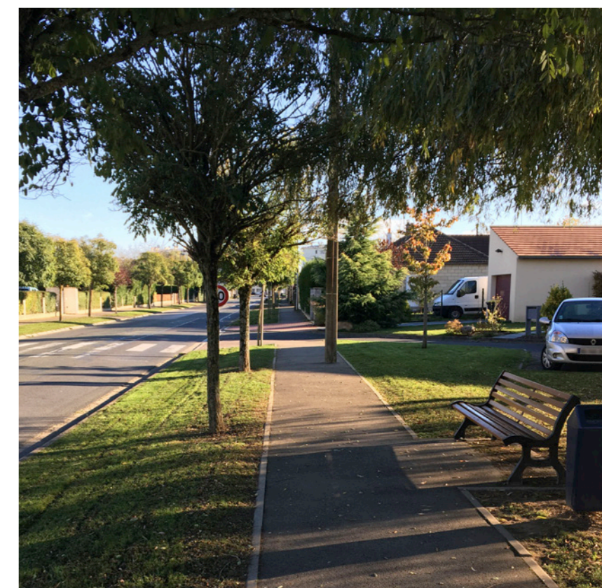
Aménagement de trottoir pour la gestion des eaux pluviales Avenue Gérard de Nerval
