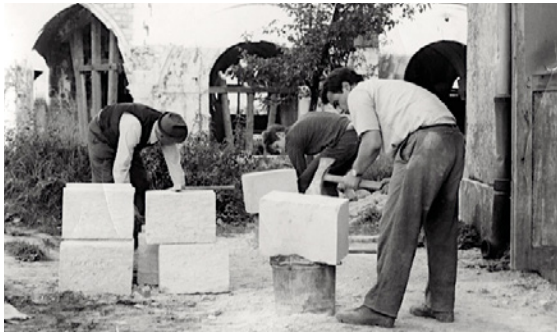
M. Planes, Duval et Tomasini taillant des pierres pour la voûte du sous-sol en 1969.
