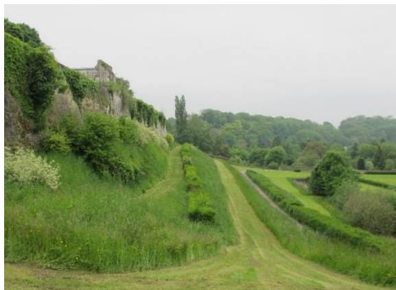
Figure 6 : Photographie du site des Remparts
