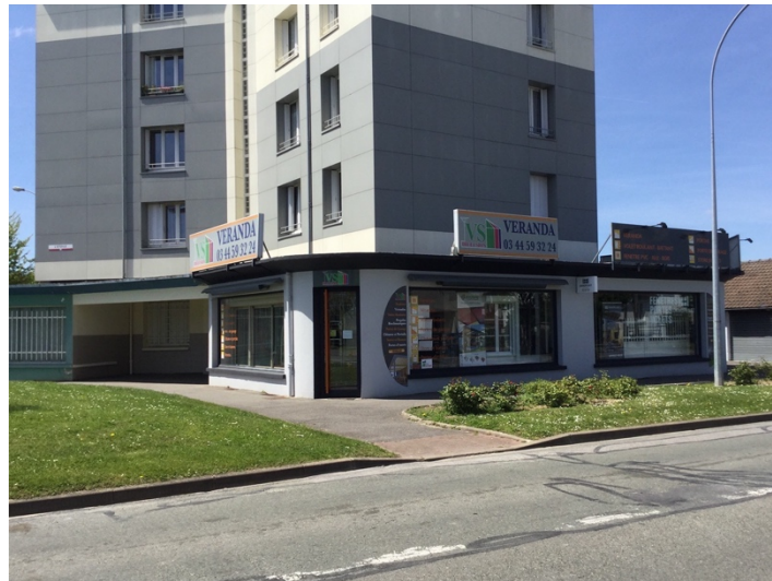
Enseigne sur toiture posant des problèmes règlementaires et paysagers
