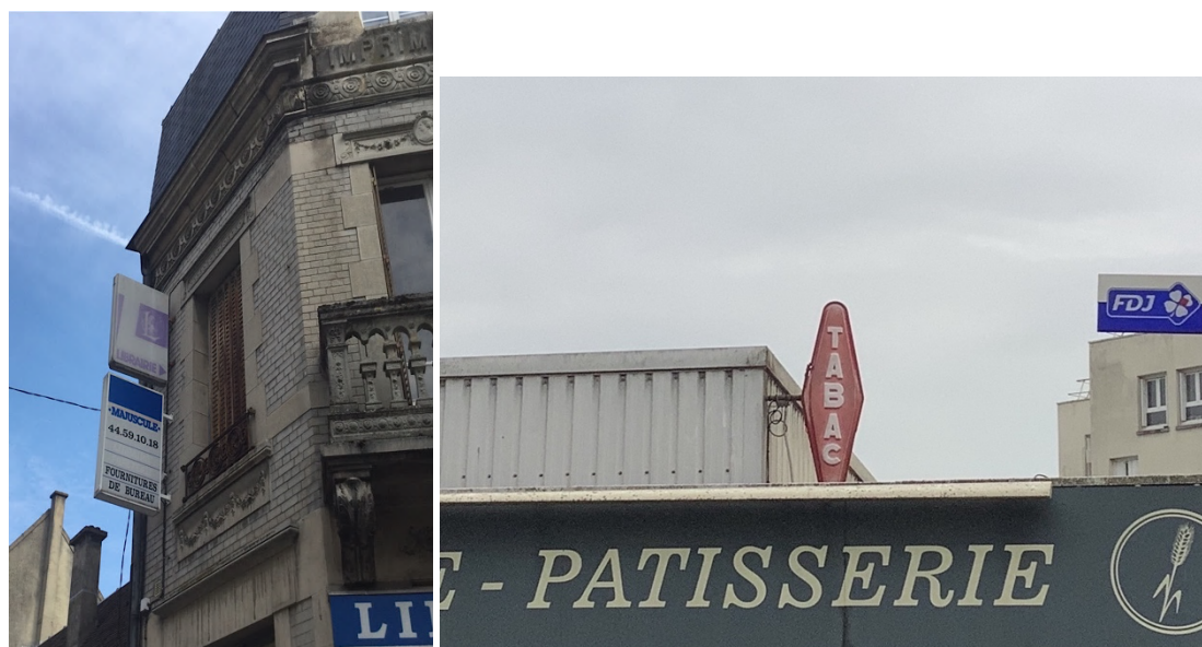
Exemples d'enseignes perpendiculaires au mur non conformes au Code de l'Environnement
