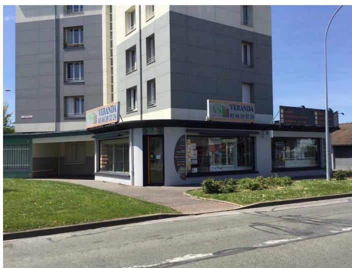
Enseigne sur toiture posant des problèmes règlementaires et paysagers
