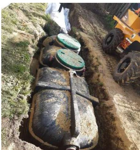
*Assainissement non collectif composé d'une filière compacte et de tunnels d'infiltration*
