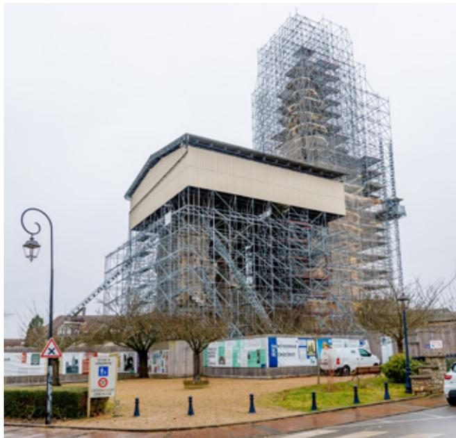
Après avoir nettoyé, restauré et remplacé les pierres en profondeur jusqu'au niveau de l'horloge, un nouvel échafaudage a fait son apparition pour continuer le processus au niveau de la flèche. Cette dernière bénéficie du même traitement que sa partie inférieure : hydrogommage, remplacement des pierres cassées et protection contre les risques liés aux conditions climatiques (pluie, gel, orages...).
