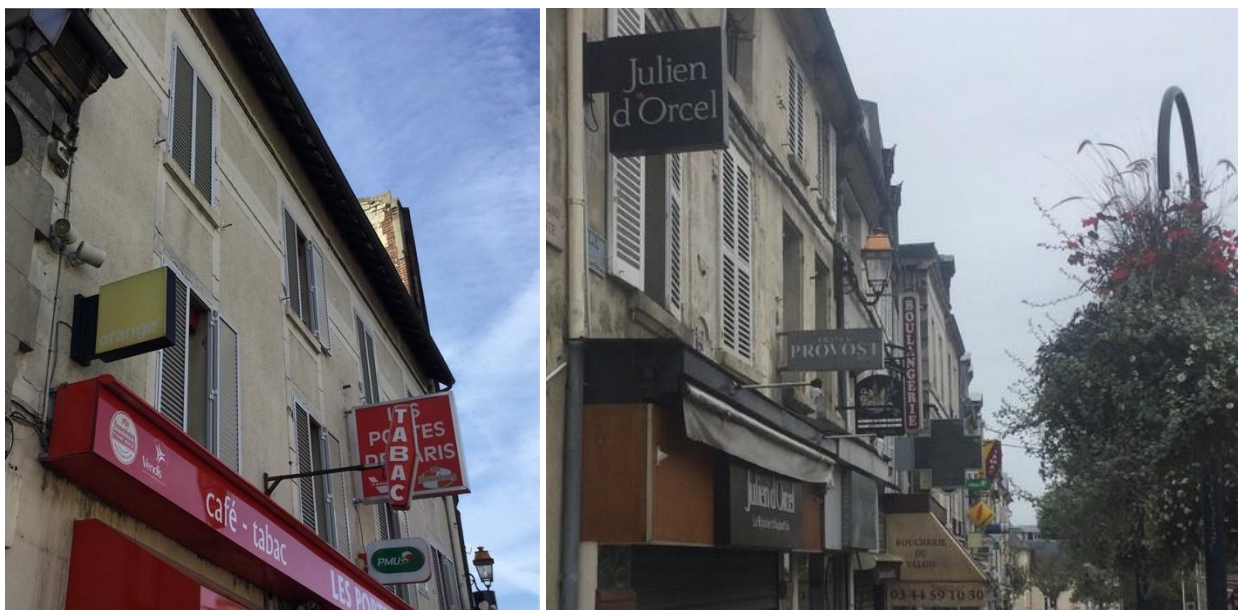
Exemples d'enseignes perpendiculaires au mur posant des problèmes paysagers
